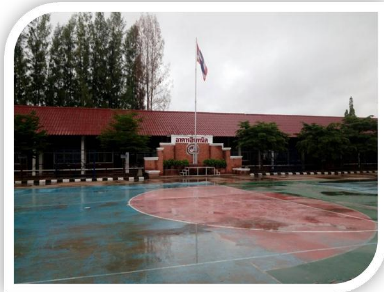
2. อาคารอินทนิล อาคารเรียน คลส. ชั้นเดียว จำนวน 11 ห้องเรียน 1 ห้องประชุม
